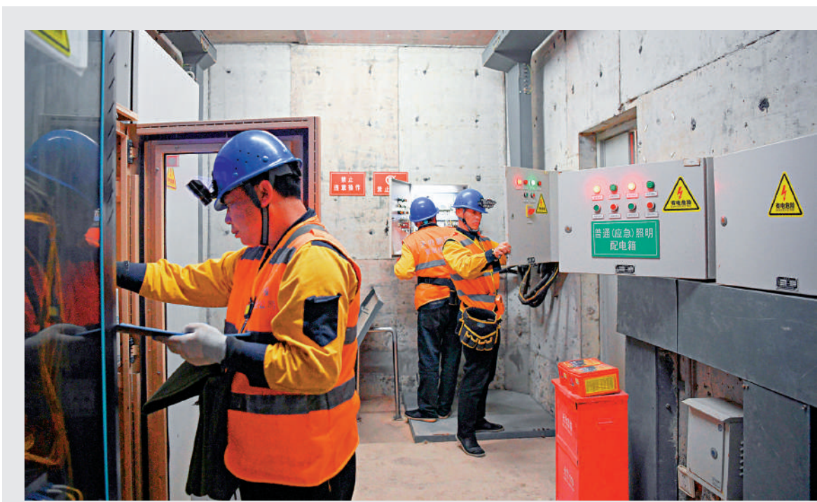
▲國務院安委會日前印發通知，部署開展高層建築重大火災風險隱患排查整治行動，聚焦有人員居住和活動的高層民用建築。圖為在四川天府新區雅州路綜合管廊，工作人員在設備層檢查水泵、消防、配電設施。
