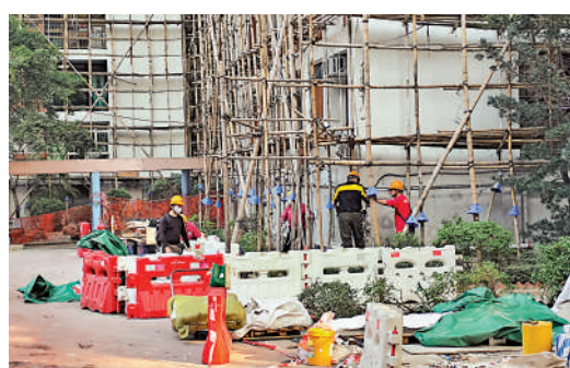
▲穗禾苑有工人正在進行拆棚網收尾工作。大公報記者古倬勳攝
