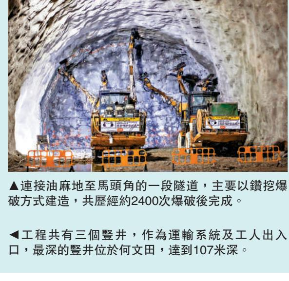
▲連接油麻地至馬頭角的一段隧道，主要以鑽挖爆破方式建造，共歷經約2400次爆破後完成。
