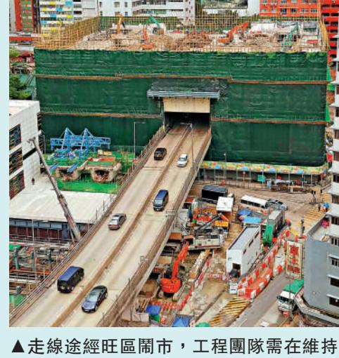
▲走線途經旺區鬧市，工程團隊需在維持加士居道天橋交通的情況下，分階段重置天橋及拆卸油麻地停車場大廈，以興建隧道。
