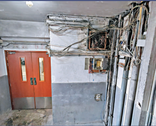
▲紅磡一座工業大廈有樓層的電線亂纏外露，容易引起火警。
