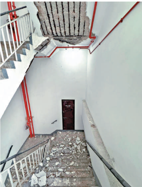
▲柴灣角街一幢工廈有後樓梯的天花鋼筋外露，石屎嚴重剝落，碎石幾乎覆蓋整條樓梯。
