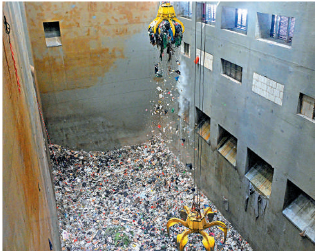
▲都市固體廢物傾倒至垃圾儲存坑，透過持續維持負壓狀態，防止垃圾氣味外洩。
