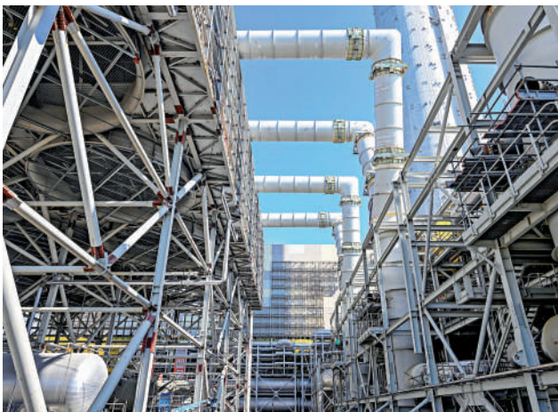
▲I·PARK1內的空氣冷凝器，高溫蒸汽通過渦輪發電機後排出至空氣冷凝器冷卻。
