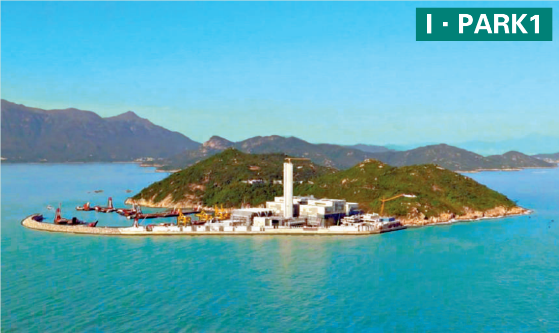
◀I·PARK1位於石鼓洲西南面的人工島，佔地約12公頃，共設有三個焚化模組。 ▲都市固體廢物傾倒至垃圾儲存坑內，垃圾儲存坑透過持續維持負壓狀態，防止垃圾氣味外洩。
