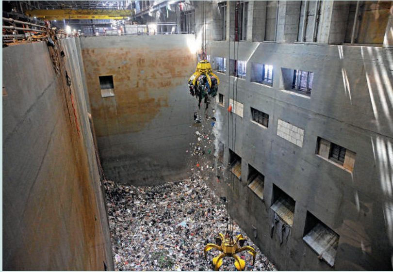
◀I·PARK1位於石鼓洲西南面的人工島，佔地約12公頃，共設有三個焚化模組。 ▲都市固體廢物傾倒至垃圾儲存坑內，垃圾儲存坑透過持續維持負壓狀態，防止垃圾氣味外洩。
