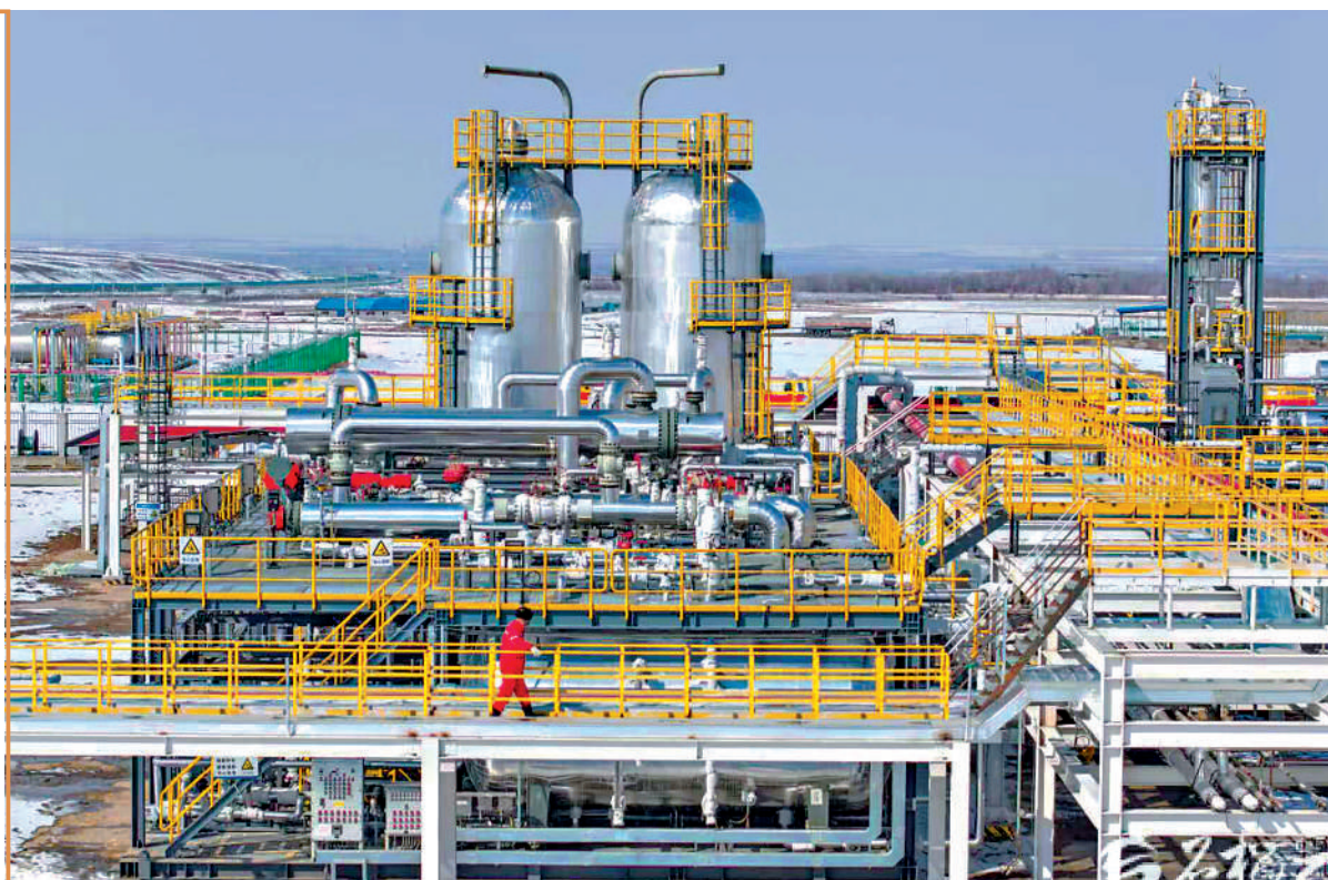
▲3月18日，新疆油田天山氣田累產工業天然氣超10億立方米。圖為新疆油田呼圖壁天然氣處理站生產現場。 天山網
