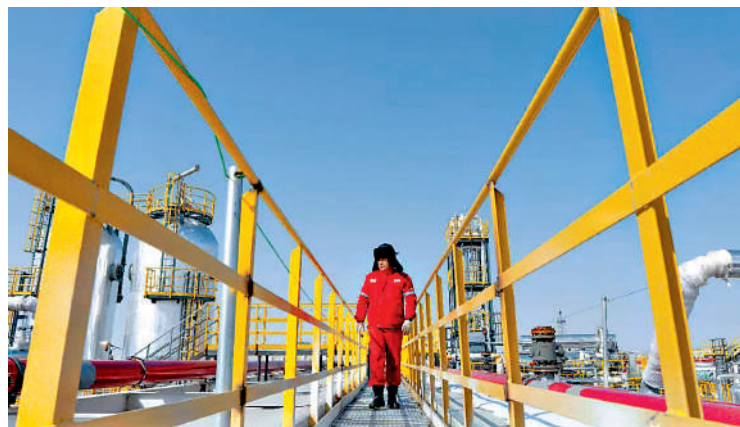
▲新疆油田採氣一廠員工正在站區進行日常巡檢。 天山網
