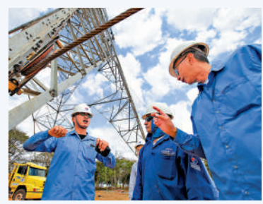
▲在巴西美麗山特高壓工程現場，中方員工在進行設備安裝。新華社
