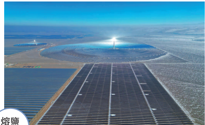
▲航拍甘肅省敦煌市光伏基地與塔式光熱電站同框。中新社
