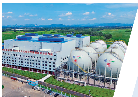
▲「十五五」開局之年，儲能項目建設有全面開花之勢。圖為中儲國能山東肥城300兆瓦先壓空氣儲能國家示範電站項目。受訪者供圖
