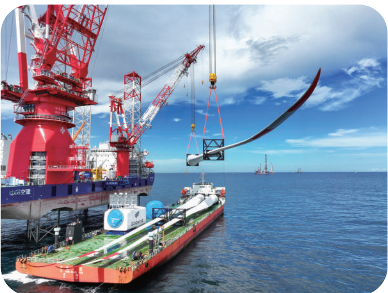
▲青洲六海上風電建設現場。 (陽江日報社供圖)
