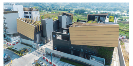
▲中電位於北部都會區的變電站。
