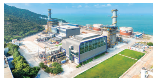
▲龍鼓灘發電廠的新燃氣發電機組。
