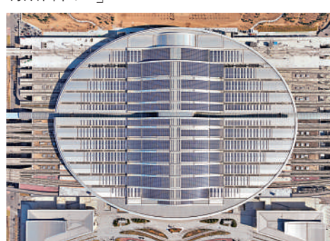
▲京雄城際鐵路雄安站裝機容量8000千瓦。新華社
