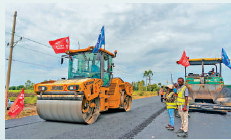
▲2月27日，中國電建的施工車輛和人員在肯尼亞甘蔗產區鋪路。
