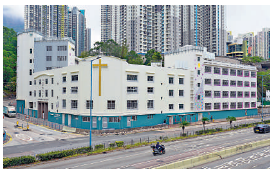
▲房屋局今明兩年將完成興建全部約3萬個「簡約公屋」單位。圖為上月入伙的彩石里簡約公屋。
