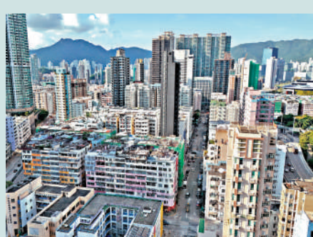
▲香港舊樓林立，運用科技進行維修有很大空間。
