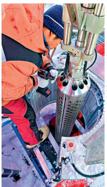
工作人員在進行熱水鑽具的安裝工作。
