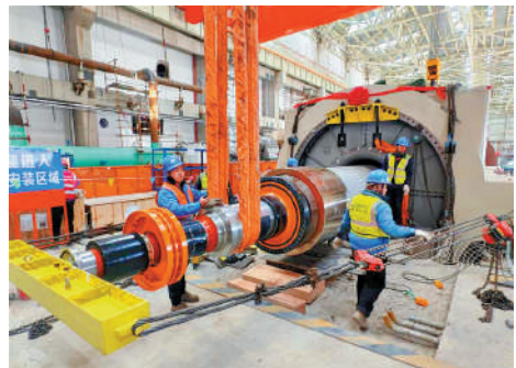
▲商洛發電二期工程3號發電機轉子早前穿裝成功。
