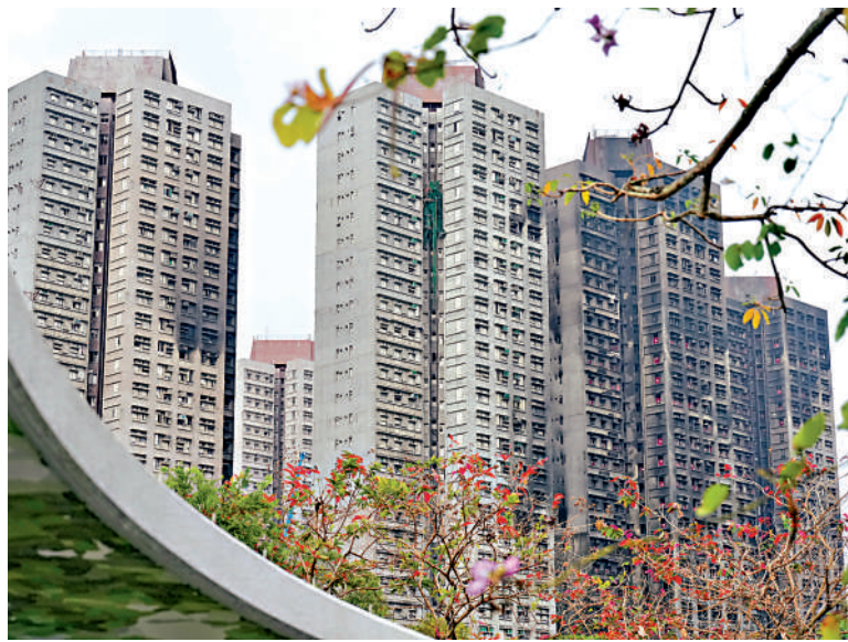
▲宏福苑大火揭示樓宇消防漏洞。
