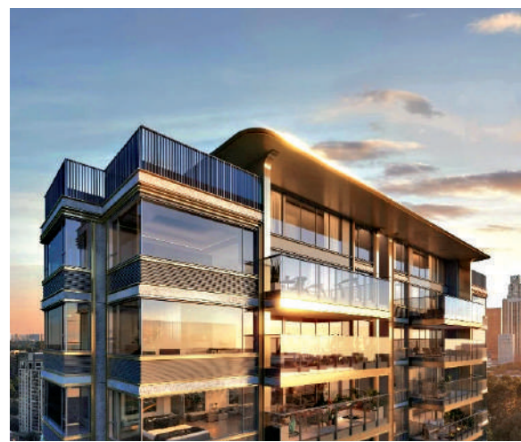
▲星河·餘蔭溪谷為低密度板樓住宅，外形現代化，充滿豪宅氣派。
