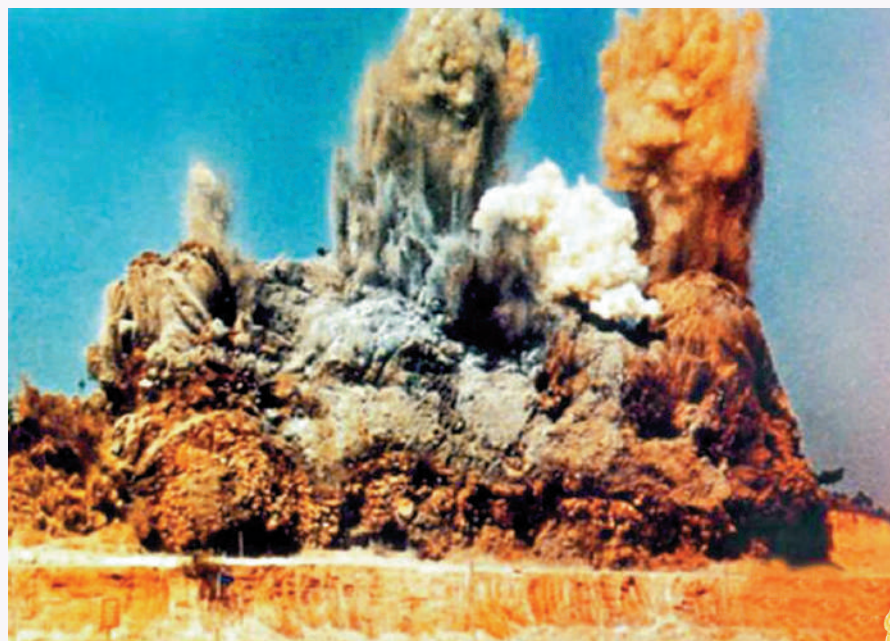
▲深圳蛇口工業區的建設者點燃開山炮。
