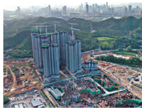
▲古洞發展區各項基建工程如火如荼。
