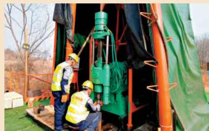
▲大東溝金礦鑽探工程施工現場。大公報記者宋偉
