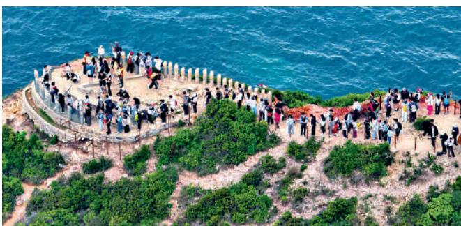
▲破邊洲觀景台「打卡」熱點完成加裝額外圍欄工程，避免遊客走近危險地方。
