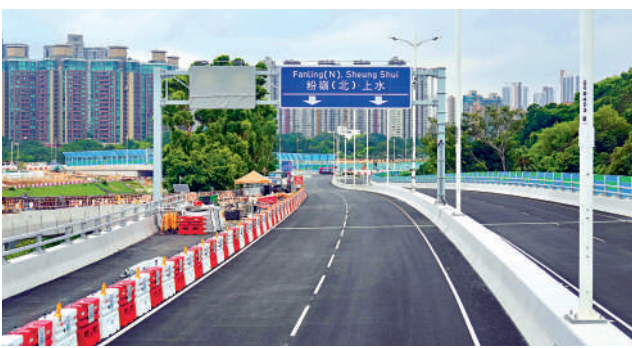
▲粉嶺繞道（東段）的龍躍頭交匯處採用「三層式結構」，包括行車隧道、地面迴旋處及高架行人天橋。
