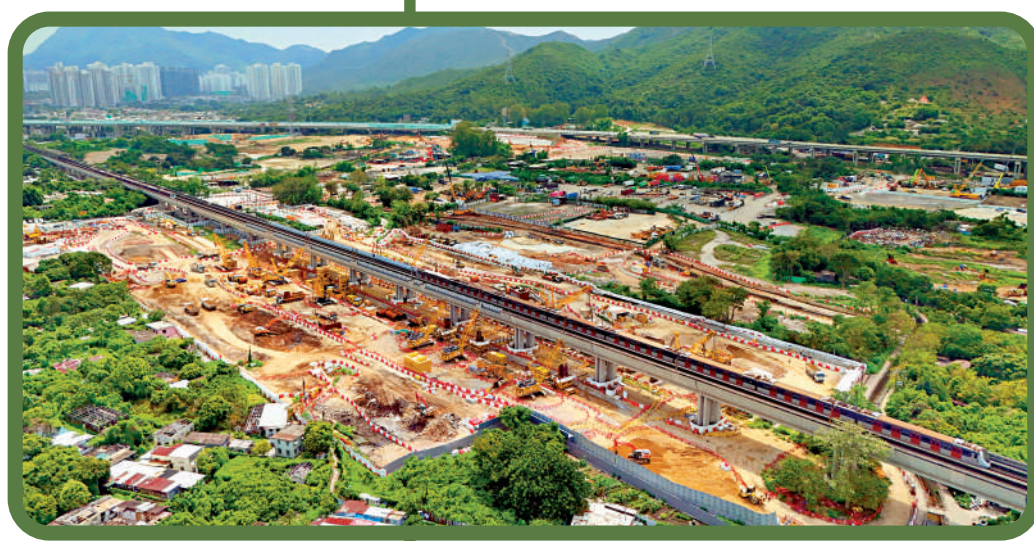
洪水橋是北都較快發展地區之一，圖為興建中的屯馬綫洪水橋站。大公報記者凱揚攝
