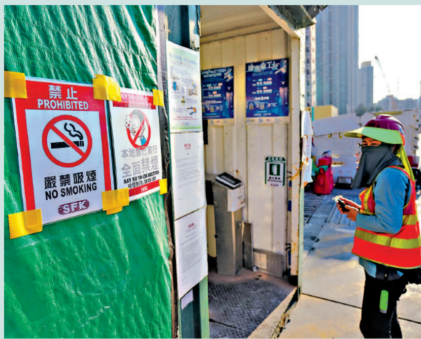
▲政府將修訂法例實施地盤全面禁煙，而不少地盤現時已自行落實禁煙措施。
