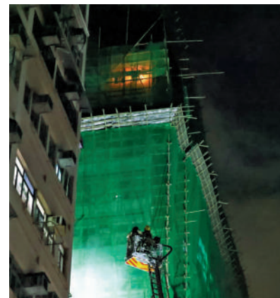
正進行維修的佐敦文苑樓一高層單位發生火警，大廈外牆搭有棚架和圍網，消防在起火單位內發現一具焦屍，另有五人受傷。大公報全媒體記者林兆禧攝
