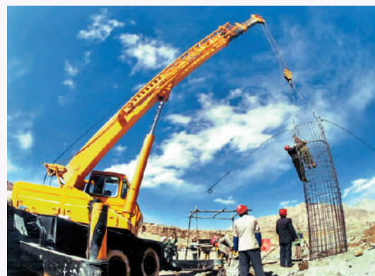
▲2001年6月29日，西部大開發標誌性工程——青藏鐵路全線開工。
