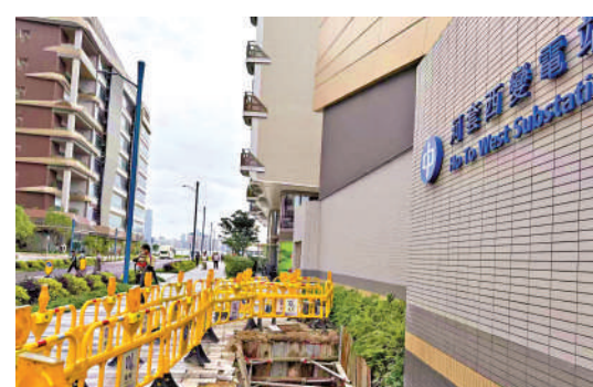
▲中電為沙嶺項目提供三路電源，確保電力供應不會中斷。圖為河套西變電站。
