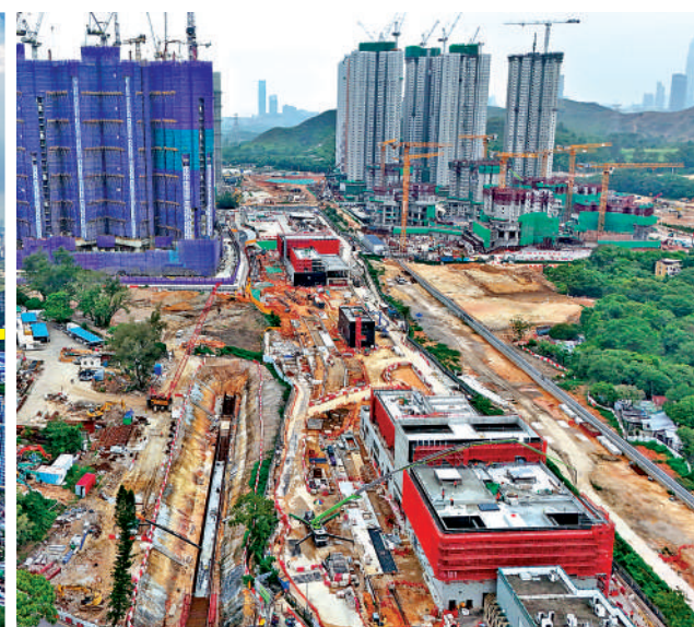
▲古洞站項目正全力推進車站的機電及室內裝備工程，預計項目可如期於2027年底竣工。 大公報記者凱揚攝
