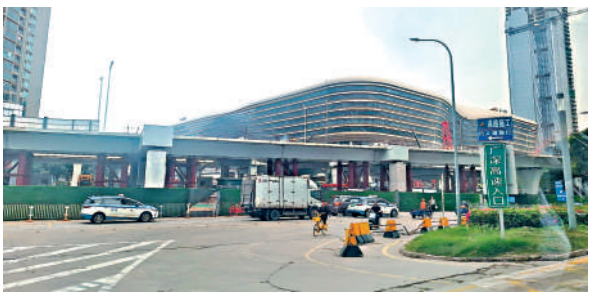
▲鄧炳強透露，新皇崗口岸的聯檢大樓建築工程已經基本完成，兩地政府均期望能盡早啟用以便利市民。
