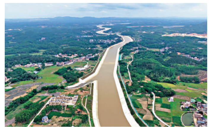
▲平陸運河舊州航拍。受訪者供圖
