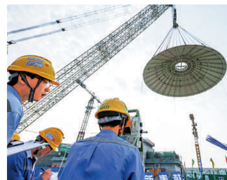
▲2月6日，在海南昌江，全球首個陸上模塊化小型核反應堆「玲龍一號」外穹頂吊裝完成。
