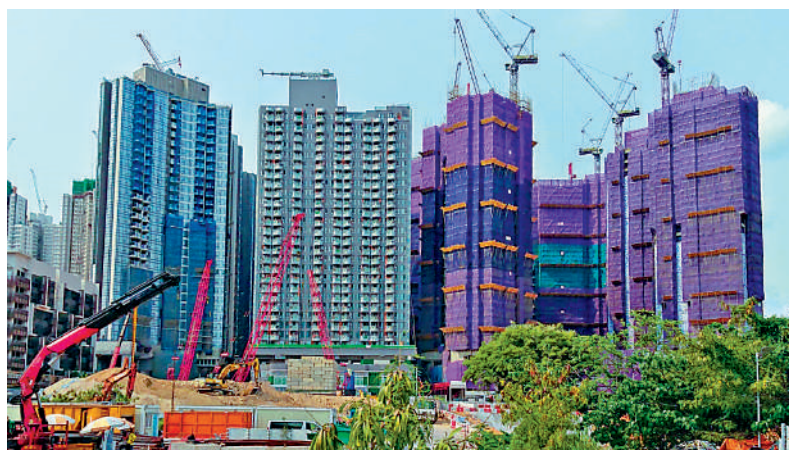
▲恒地旗下上水古洞北鄉梓路25號項目(中)，預計今年9月落成。左為會德豐地產鄉梓路23號項目。
