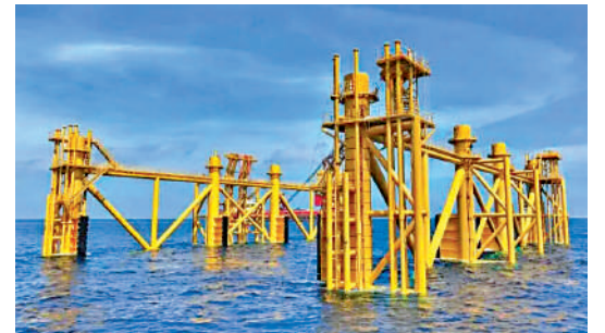
▲「海風之心」的萬噸級鋼結構導管架早已在廣東陽江預先沉放就位。
