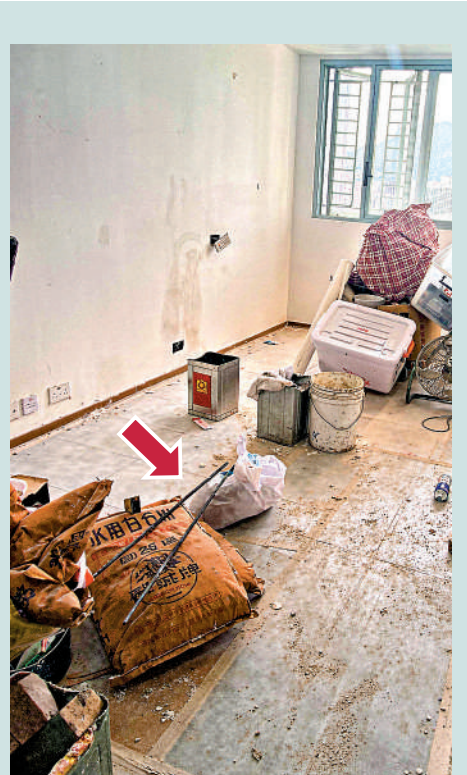
▲宏緻苑C座某單位內，懷疑有從主力牆內拆出來的兩條鋼筋。大公報記者李茶攝
