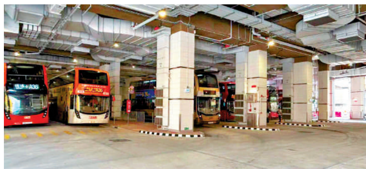
▲港鐵錦上路站D出口外的新公共運輸交匯處，昨日起全面啟用。
