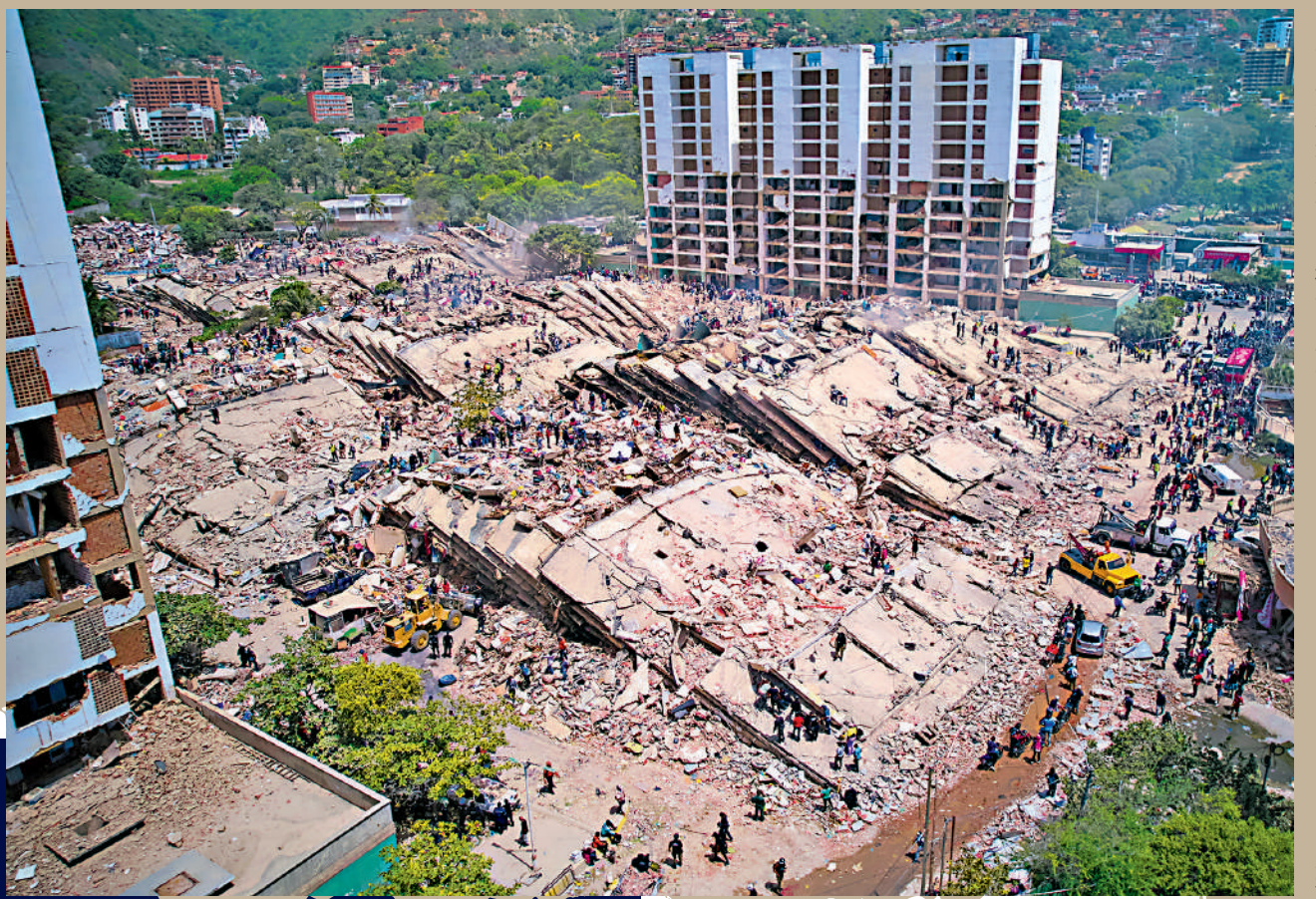
委內瑞拉地震後，多棟住宅倒塌。
