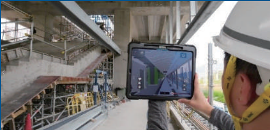
▲工程人員於東涌東站利用擴增實境(AR)進行工地巡查。
