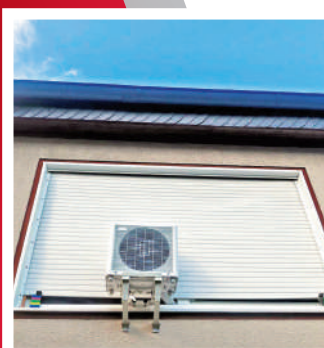
▲PortaSplit空調的窗口支架無需改造外牆便可安裝使用。
