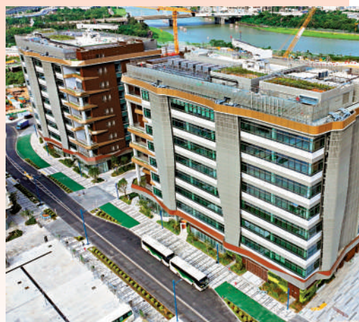
▲立法會昨日通過向香港科技园公司注資37億元，以支持加快完成港深創新及科技园第一期基建及公用設施。
