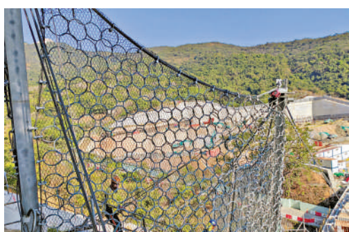
▲理大研發的「柔性防護網」在薄扶林斜坡工程中率先應用。
