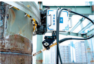
▲項目團隊引入「機器人軍團」。圖為中建鋼構焊接機器人。受訪者供圖
