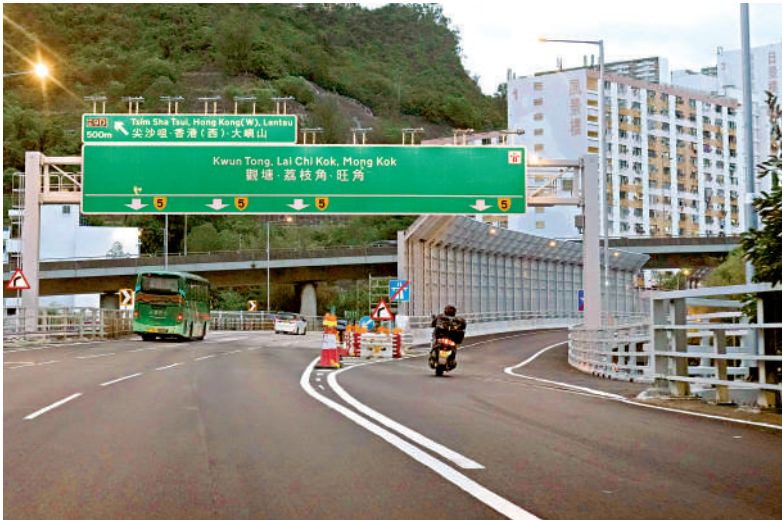
▲新行車橋為快車道，若駛近道路分岔口時才發現走錯道，突然減速易造成意外。
