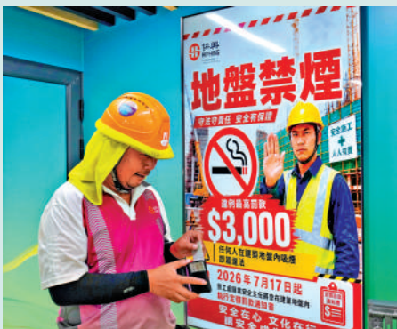
▲有地盤入口處張貼「地盤範圍 嚴禁吸煙」、「一經發現 鎖咭離場」等告示。
