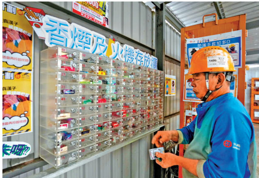
▲土瓜灣一個建築地盤在入口處設有儲煙櫃，工人將香煙和打火機放入櫃才能入地盤。
