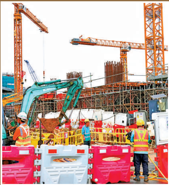
▲北都已邁入大規模施工階段。
