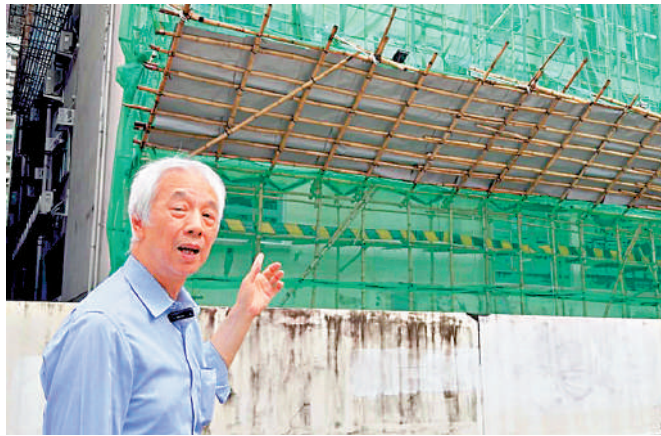
◀石先生表示，工程已經完成，正等待屋宇署檢驗後刷漆完工。
