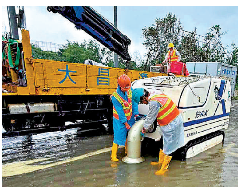
渠務署 ▲渠務署緊急應變隊伍及強力排水機械人「龍吸水」，昨日在屏山橋街處理水浸。
