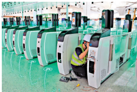
▲工作人員在調試皇崗口岸旅檢大廳自助通道的「三道門」一體化閘機。
