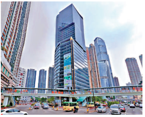
▲中環傳統金融核心區的寫字樓空置率，已明顯回落。
